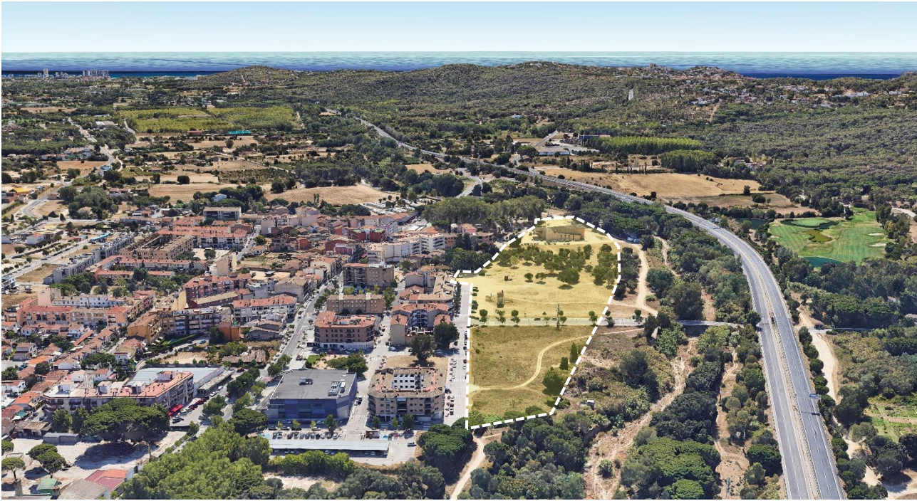
VISTES ÀÈRIES DEL SECTOR I EL SEU ENTORN URBÀ I NATURAL. L'ÀREA MARCADA CORRESPON ALS 4,68HA DE SÒL URBANITZABLE SEGONS LA DEFINICIÓ DEL SECTOR DEL POUM 2024. S'OBSERVA LA POSICIÓ ESTRATÈGICA COM A FAÇANA DEL NUCLI URBÀ I LA FRANJA DE TERRENY – FRONTISSA CAP A LA LLERA DEL RIDAURA I LA CARRETERA C-65/C-31.
