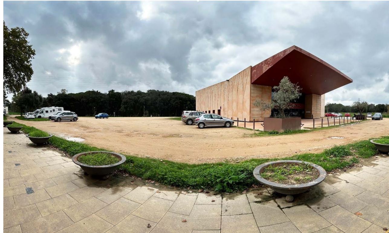
FIGURES 6 I 7 ESTAT ACTUAL DEL SECTOR – FOTO DE L'EQUIPAMENT PÚBLIC (ESPAI RIDAURA) AMB L'APARCAMENT INFORMAL EXISTENT AL SEU VOLTANT I FOTO DE L'AVINGUDA RIDAURA EN EL CENTRE DE L'ÀMBIT, MIRANT CAP AL FRONT URBÀ
