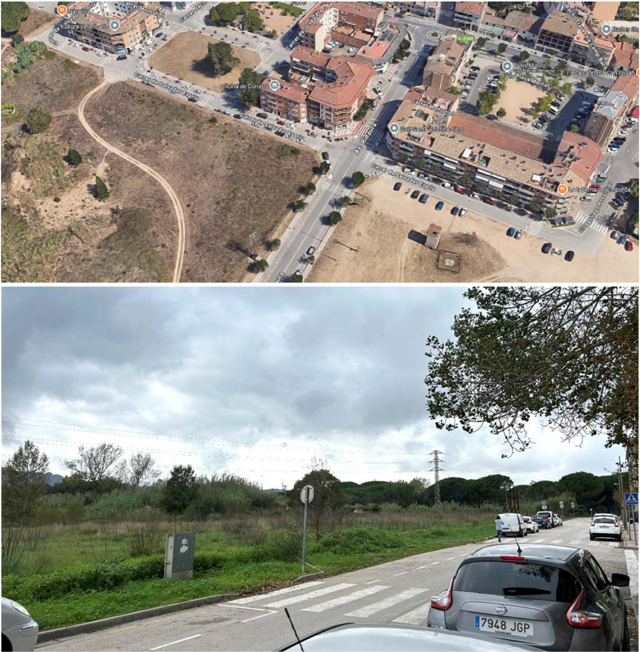
FIGURES 41 I 42 PUNTS DE L'ITINERARI D'ACCÉS DES DEL CENTRE URBÀ. TRAM URBANITZAT DEL CARRER SALVADOR ESPRIU
